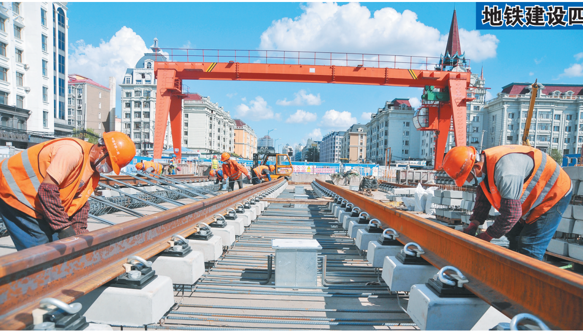
地铁2号线施工正在进行特殊减震道床施工。本报记者 苏强摄
