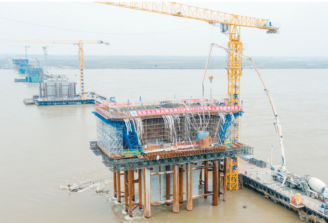
鹤岗高速佳木斯过境段项目二标段松花江特大桥施工现场,58号主墩0号、1号块顺利浇筑。
