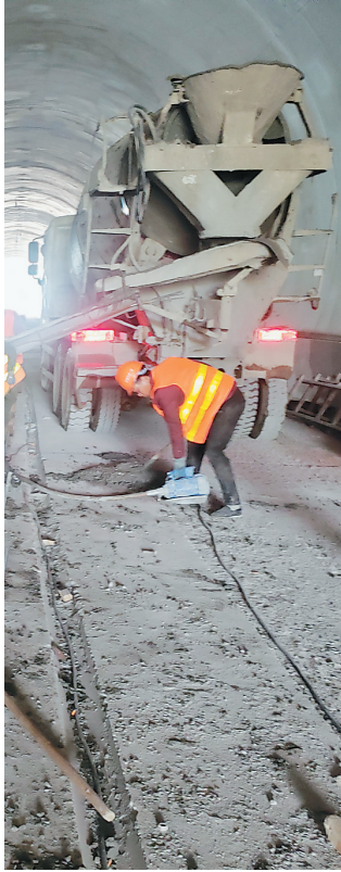
施工人员正在对无砟轨道底座板进行浇筑。
