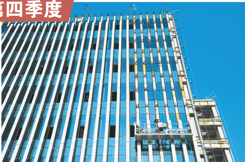
工人正紧张有序地进行幕墙安装。
