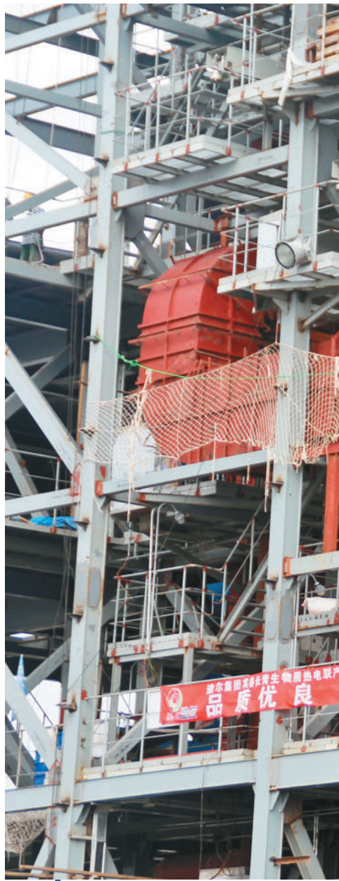
百日会战启动时正在建设中的长青生物质热电联产项目的厂房。
