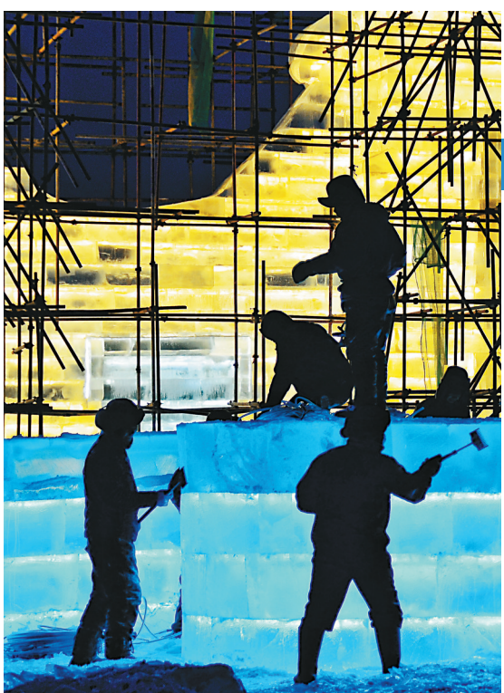
哈尔滨冰雪大世界建设现场。
