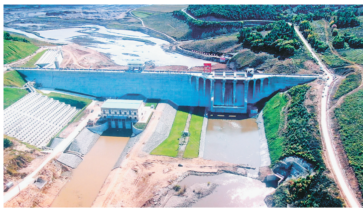
奋斗水库供水工程。
