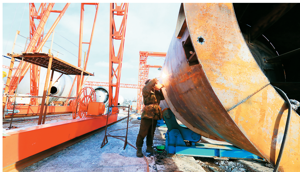
正在紧张施工的黑龙江华瑞生物医药项目施工现场。 宫芮 本报记者 姚建平摄
