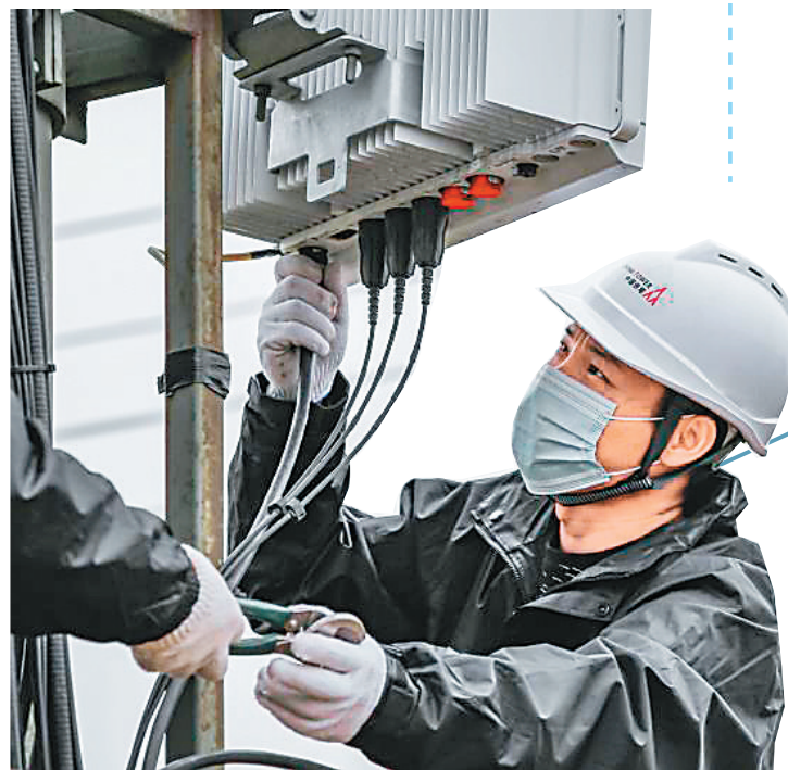
工人在建设5G基站。
