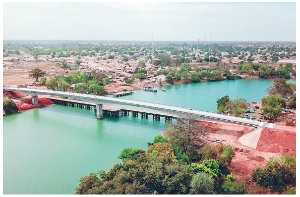
援建冈比亚上河区公路桥梁项目。
