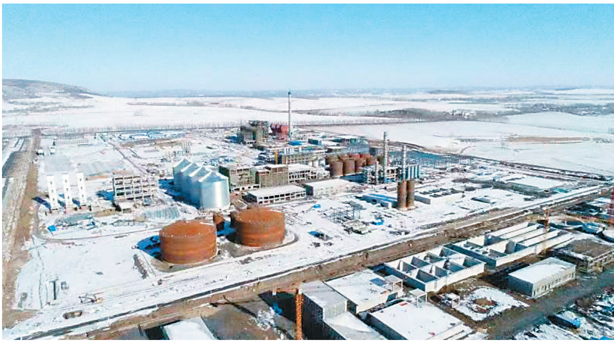
正在建设的年产30万吨乙醇项目。
