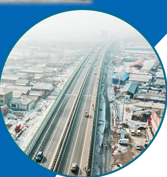
尚志市公铁立交桥项目建成通车。
