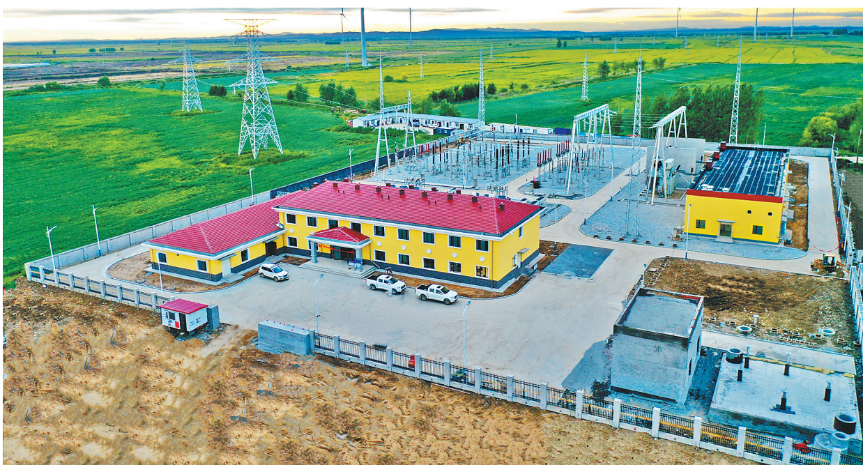
华能萝北风力发电有限公司200兆瓦升压站。
