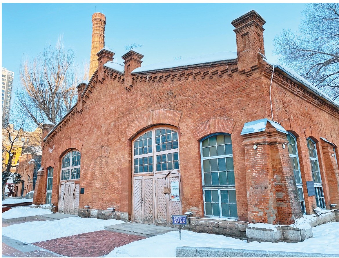
原东省铁路哈尔滨总工厂锻造分厂，1903年动工修建，1907年建成。
