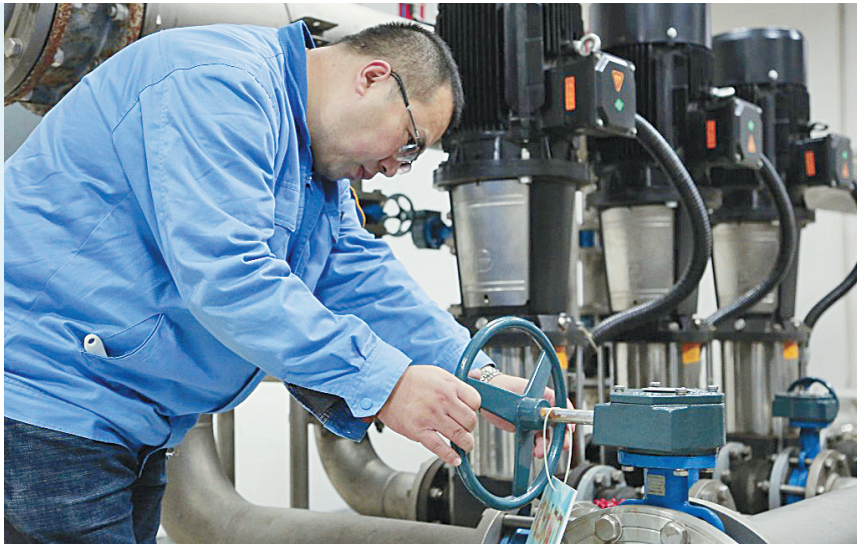
工人在检查已改造安装的二次供水设施。
