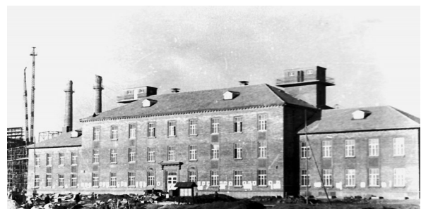
1955年竣工的公司办公楼总办公厅土建竣工（1955年10月27日）。
