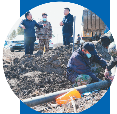
铁力农场有限公司为大棚区居民更换用水管道。张朝钊摄
