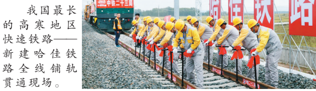
我国最长的高寒地区快速铁路——新建哈佳铁路全线铺轨贯通现场。
