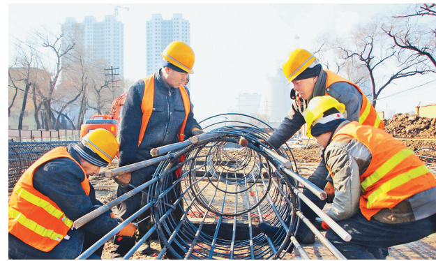
中铁二十三局集团二公司哈牡铁路电气化改造工程现场。
