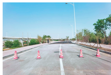
工作人员正在准备施画路面标线。
