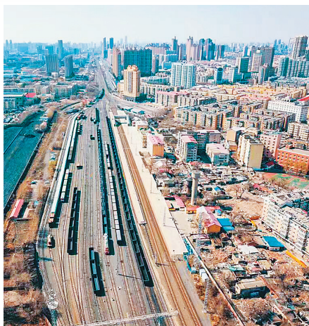
俯瞰香坊火车站周边拆迁区域。 图片由文保志愿者提供
