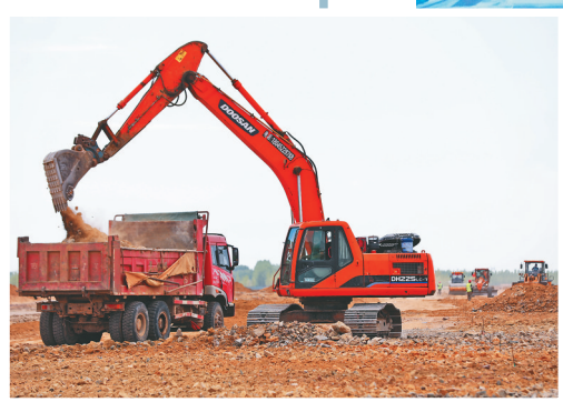
大机械助力施工。
