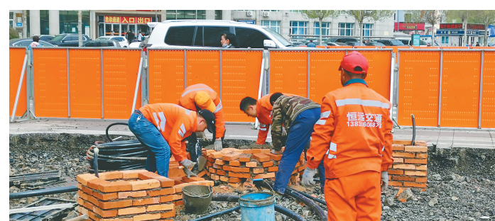
长安路施工现场。 宋洋摄
