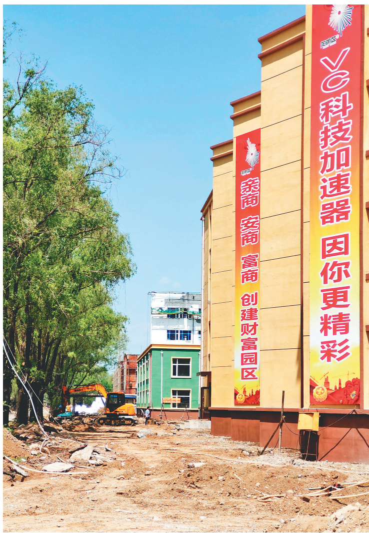
园区施工现场。黑龙江日报全媒体记者 刘晓云摄
