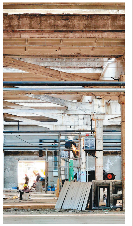
厂房内部正在施工。黑龙江日报全媒体记者 刘晓云摄
