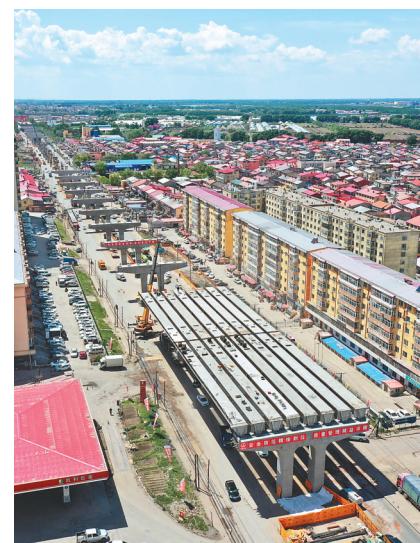
无人机拍摄施工现场。
