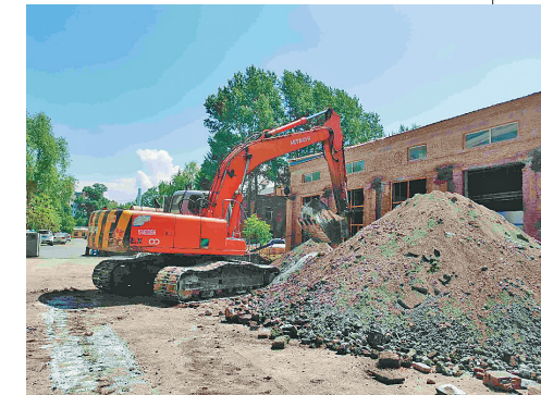
现场机器施工。
