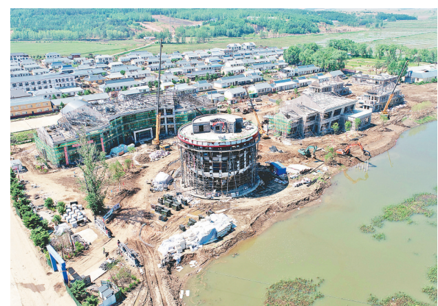
作为第四届旅发大会核心观摩项目的西安区中兴汽车营地·民宿酒店项目正按照预期进度进行施工。“琴鼓”接待中心钢结构龙骨安装工程、钢结构铺装工程,各主体建筑内墙抹灰、防水等室内工程已经启动,人工湖北岸砂石路路路基础设施已经完成。整体项目预计7月下旬投入试运营。 文杰 刘玥婷摄
