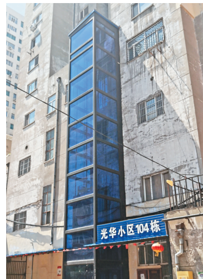
道里区光华小区104栋安装的电梯。
