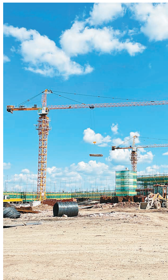
宾县中北食品肉制品加工及冷链运输项目建设现场。
