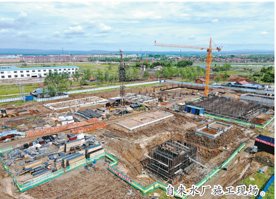
自来水厂施工现场。
