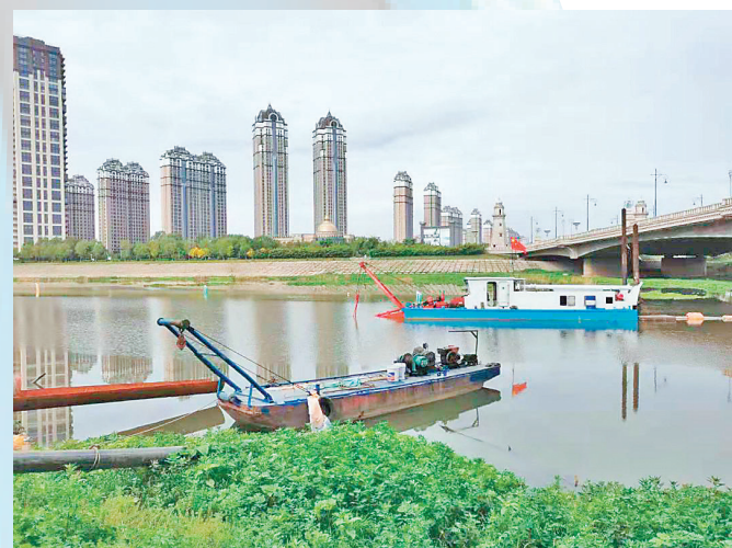
何家沟清淤现场。
