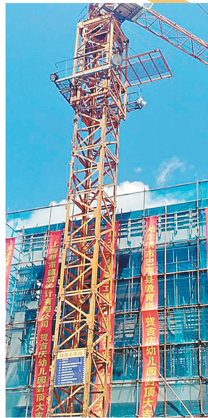
巴彦县公立幼儿园工程封顶。
