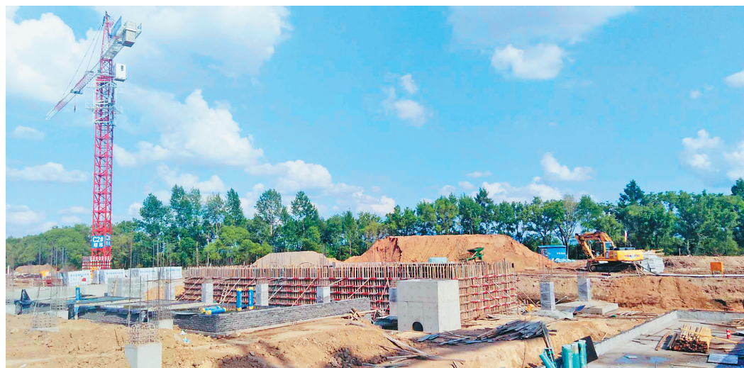
延寿县新供水厂建设施工现场。
