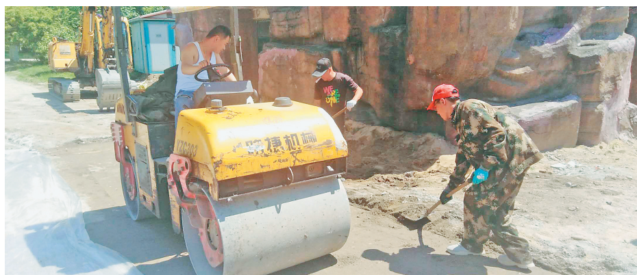
健身步道项目正施工。
