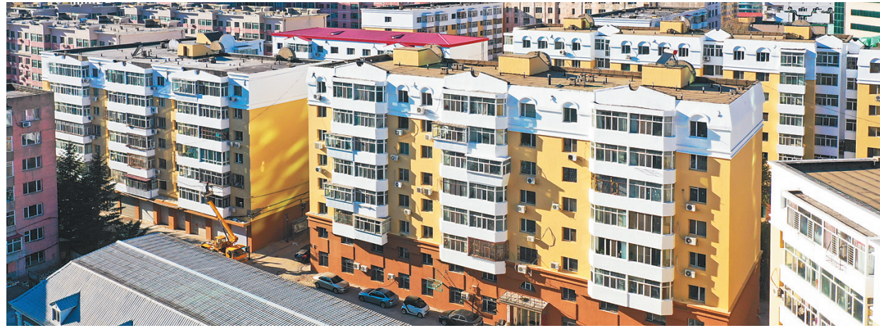
香坊区威朗小区已完成全部工程,等待竣工验收。
