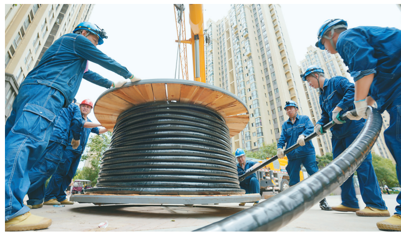
雁鸣小区抢修现场。
