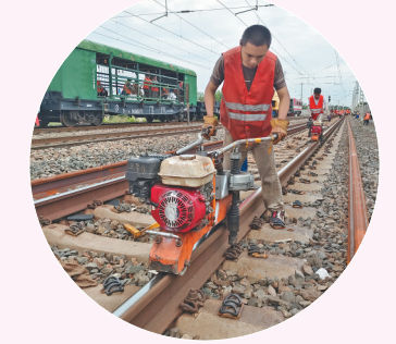
图为线路工正在进行换轨施工。 张学鹏 黑龙江日报全媒体记者 狄婕摄
