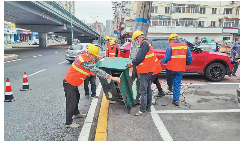
哈市街头废弃电闸箱体拆除中。
