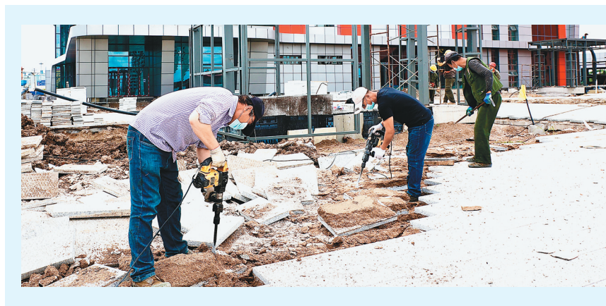
省百大项目——讷河市公铁联运客运枢纽项目二期工程现场,施工人员严格按照疫情防控规定和规范标准进行作业,保证在安全前提下如期完工,尽早方便市民出行,完善城市服务功能,提升城市形象。兴文博 黑龙江日报全媒体记者 姚建平摄
