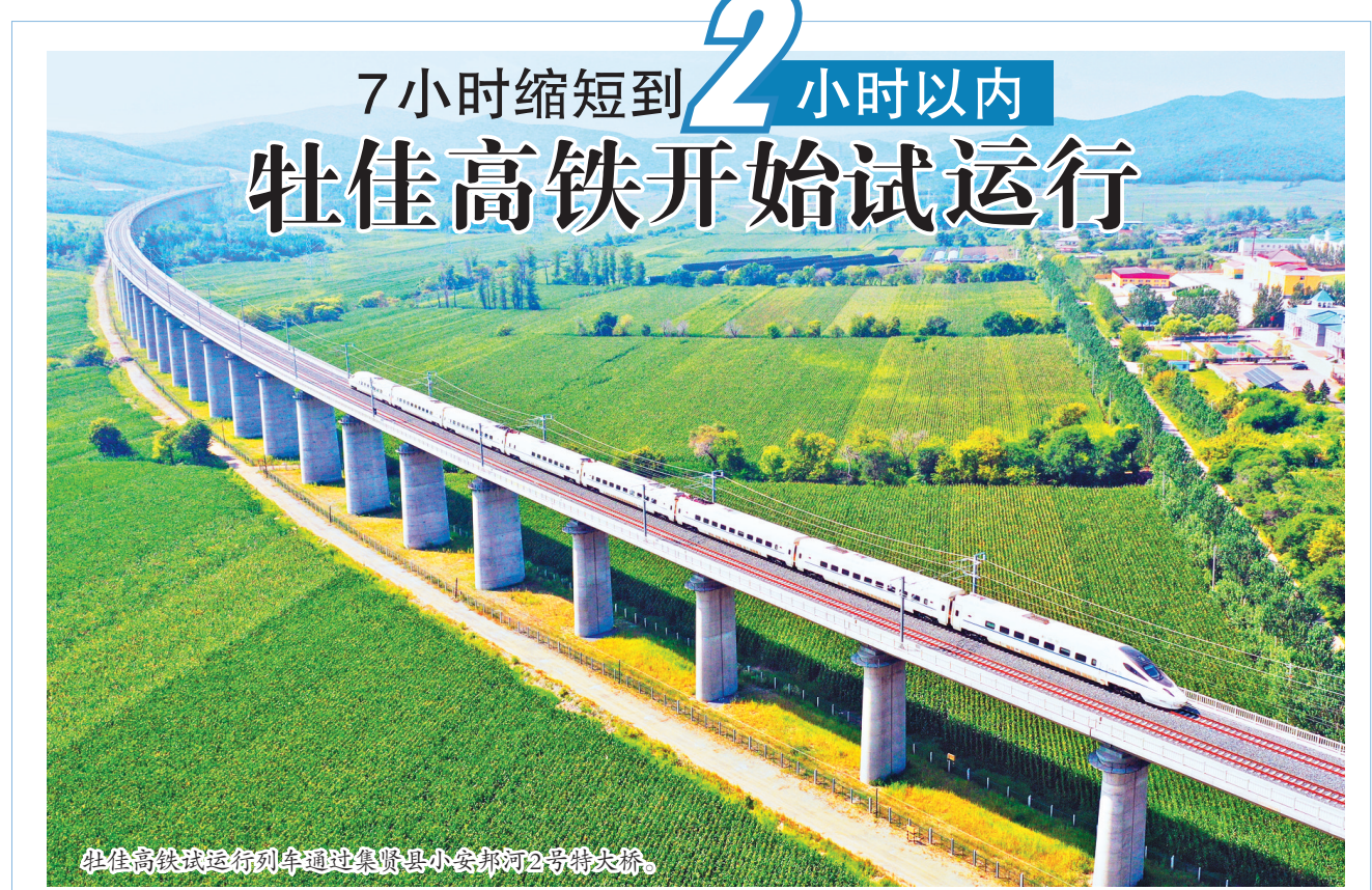
牡佳高铁试运行列车通过集贤县小安河2号特大桥。
