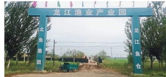
北鱼集团龙江渔业产业园施工现场正门。
