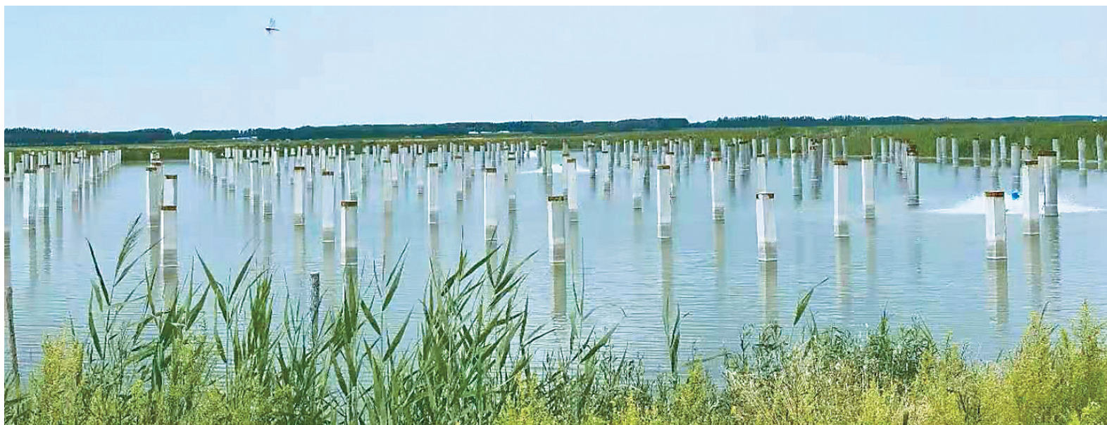
北鱼集团渔光一体光伏发电项目。
