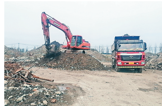
北鱼集团龙江渔业产业园施工现场。
