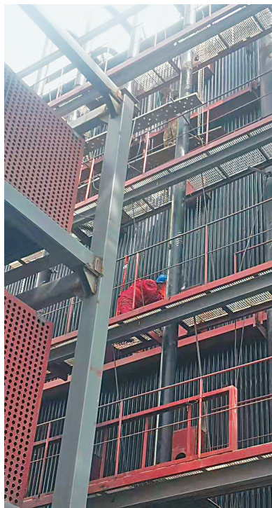
以秸秆为燃料的清洁能源供热锅炉安装完成。
