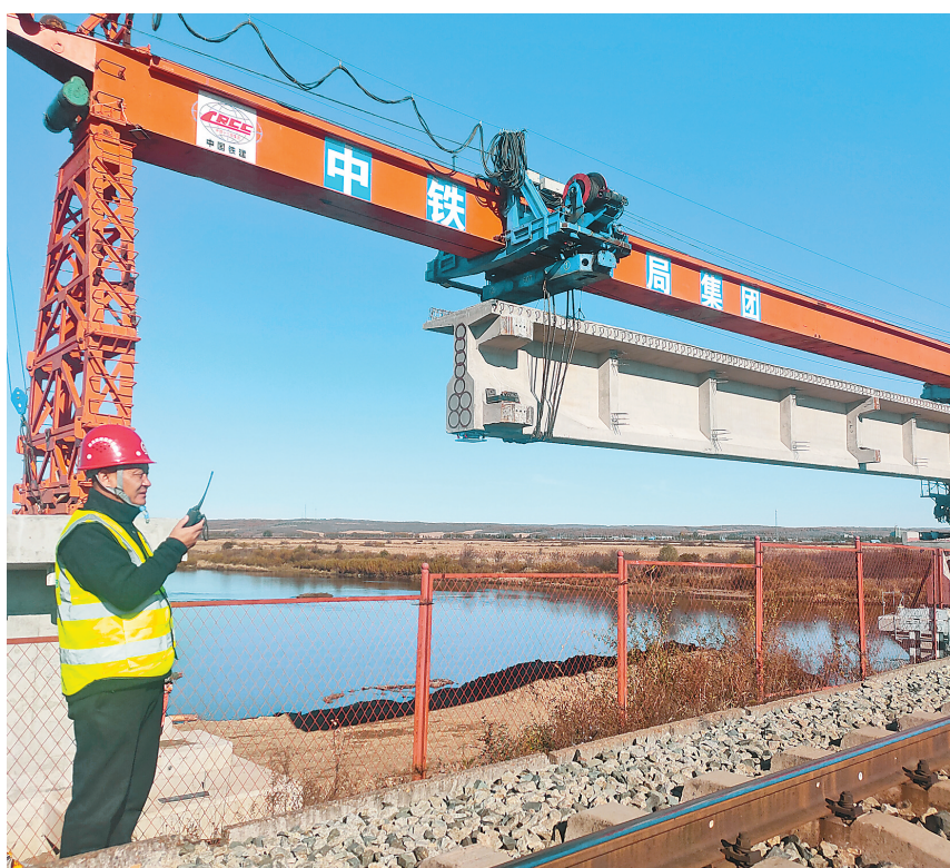
新建逊别拉河铁路大桥架设最后一根T梁。
