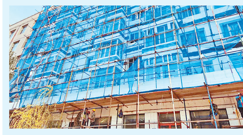
今年宾县城镇老旧小区改造项目共涉及14个老旧小区、19栋楼房,1087户居民,总建筑面积9.63万平方米。为严把工程质量关,将民生实事办好,宾县住建局聘请了第三方监理入场对整个工程实行全方位监督,从根本上保证施工质量、不留后患。
