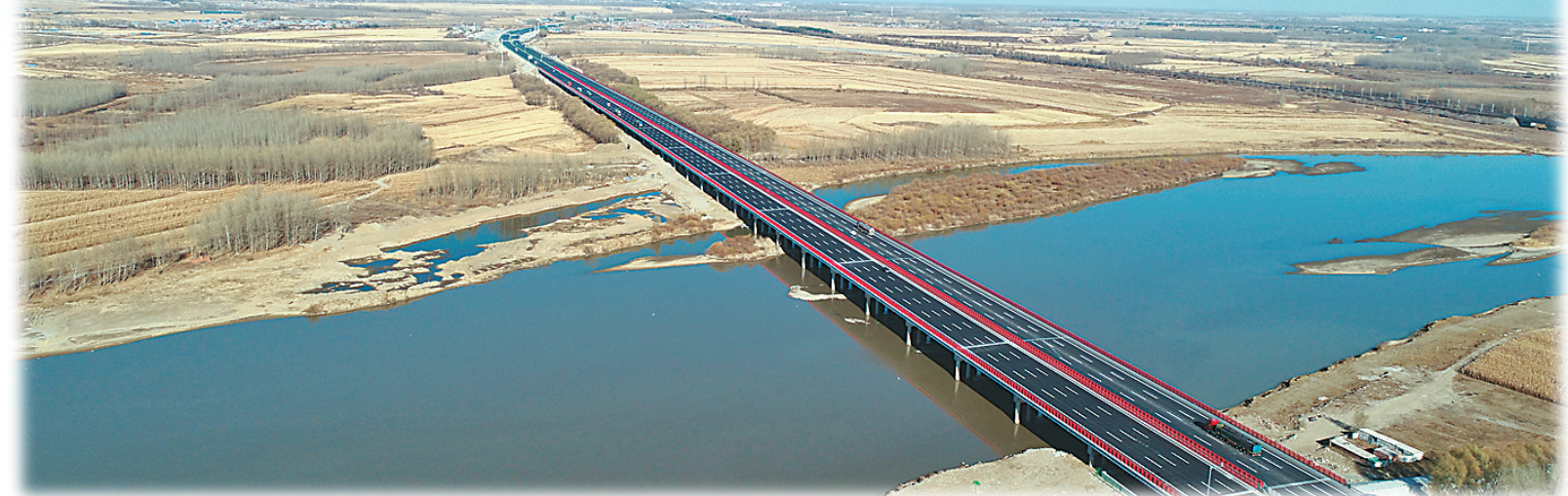
拉林河特大桥。
