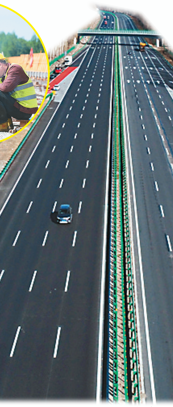
交工通车的京哈高速公路。
