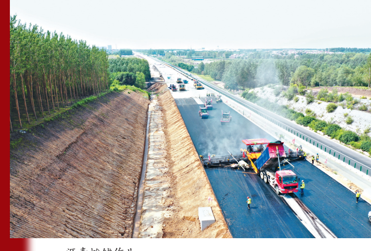
沥青摊铺作业。
