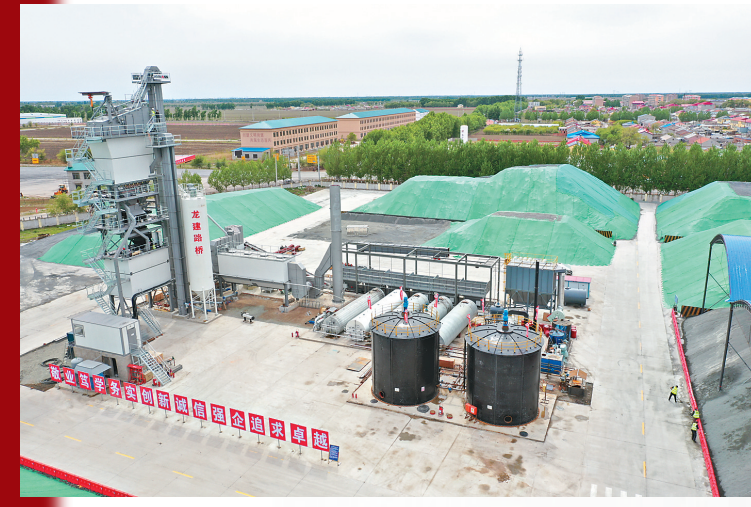
环保5000型沥青混凝土拌合站。
