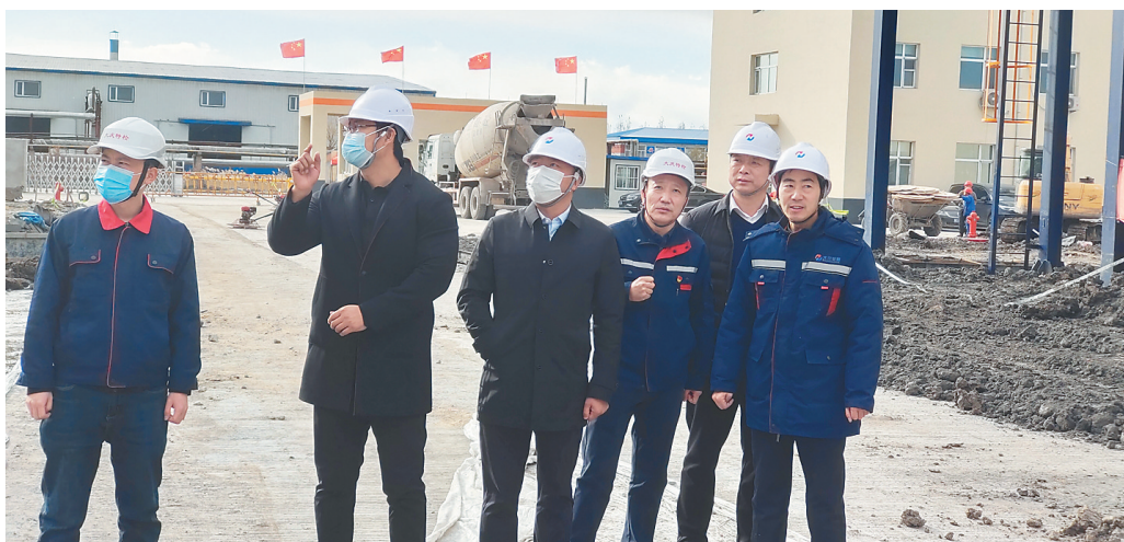
刘殿华(左二)、李凤东(左三)在施工现场。
