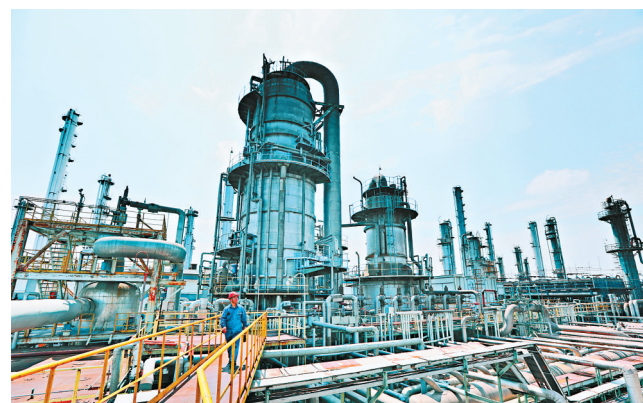
大庆石化厂区。
