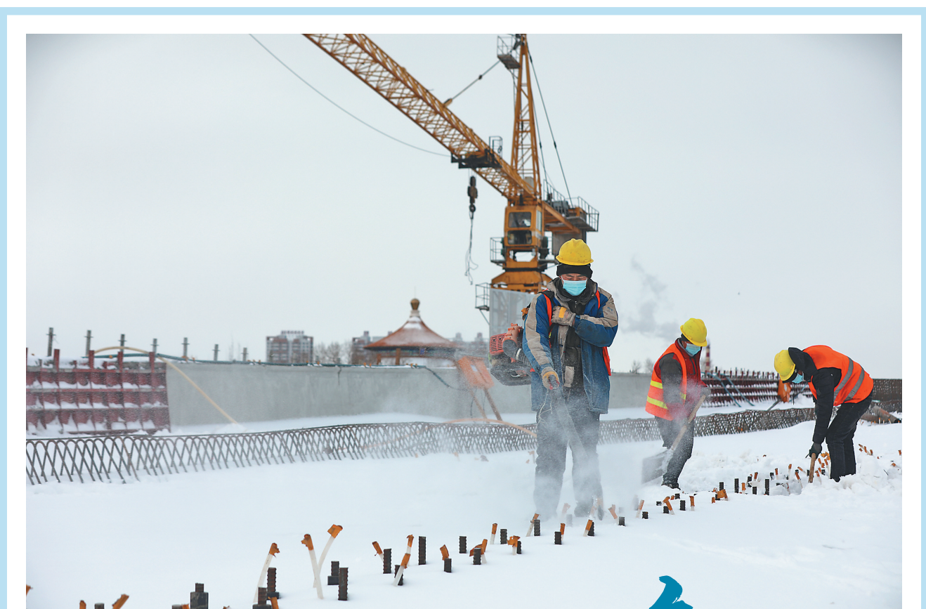
省百大项目 齐齐哈尔民航路跨线桥工程
