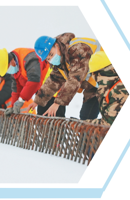
顶出出长度……“民航路跨线桥主桥7号、8号墩是承载主桥转体的关键,也是最后一道工序。其中竖向预应力张拉3天后结束,为保证A2段预应力张拉、注浆作业在11月30日前完成,现场采取了冬季施工保温措施,确保工程质量万无一失。12月初,将集中拆除7.8号桥墩的现浇连续梁支架体系,为明年主桥转体创造条件。”项目经理张时钟介绍。上图:工人们清理竖向张拉孔道的雪。右图:施工人员进行绑扎防撞墙钢筋。宋燕军摄
