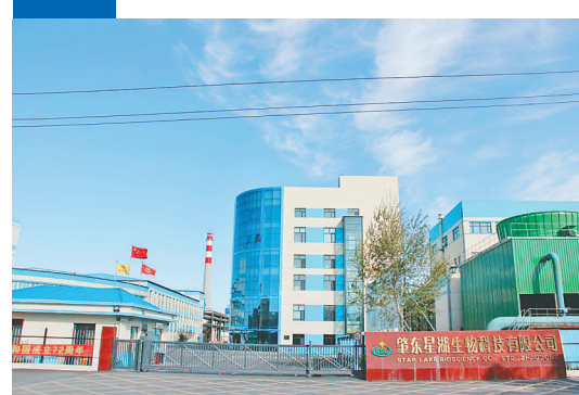
肇东星湖生物科技有限公司厂区。
