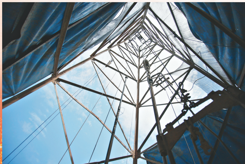
项目现场钻机作业。
