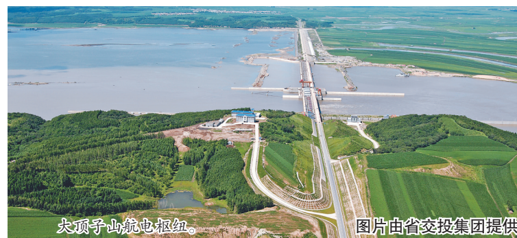
大顶子山水电枢纽 图片由省交投集团提供
