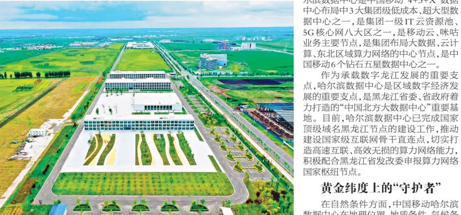
59.6万平方米，规划总装机架5.4万架，规划总投资预计达120亿元。当前已投产机架1.86万架，服务器承载能力超过35万台。
