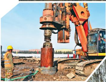
本报15日讯(黑龙江日报全媒体记者狄婕)记者从中国铁路哈尔滨局集团有限公司获悉,15日10时,伴随着旋挖机巨大的轰鸣声,直径1.5米的首根桩基在哈尔滨至伊春高铁伊段(以下简称哈伊高铁伊段)新建路鹤哈高速1号特大桥的施工现场顺利
