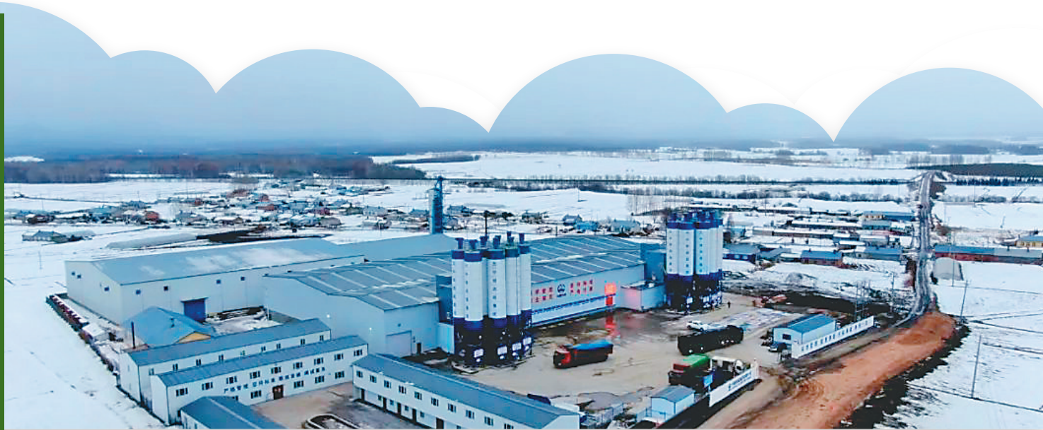
哈伊高铁伊段3月15日起全线复工。
